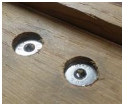
Les têtes de vis visibles sur le chemin de défilement seront à cacher avec de la pâte à bois.
