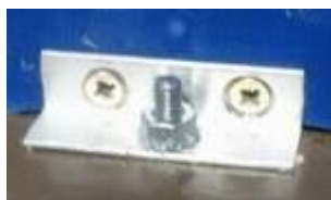
Deux petites cornières de 30 mm côté des sorties d'air
