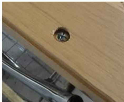
Une planche est fixée à demeure sur la tubulure - il faut noyer les têtes
