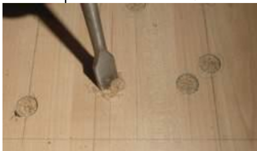
Il faut aussi prévoir le noyage des têtes de vis qui sont placées sous le plancher de l'orgue
