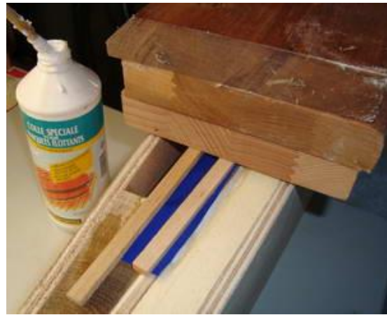
Appliquer un poids sur les peaux lors du séchage
